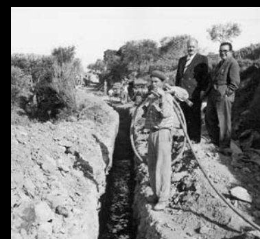
● Montagem da conduta de salmoura, em 1956, Torres Vedras
