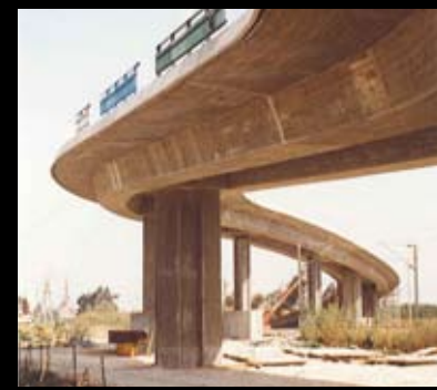
Fase de construção da ponte sobre a linha ferroviária do Norte
