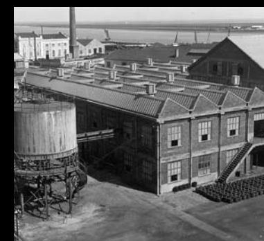
● Vista Geral da fábrica, Soda Póvoa, Póvoa de Santa Iria
